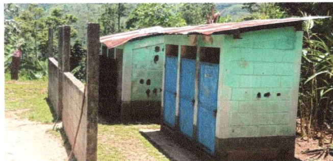
Foto 5: Reparación de puertas y sustitución de láminas
