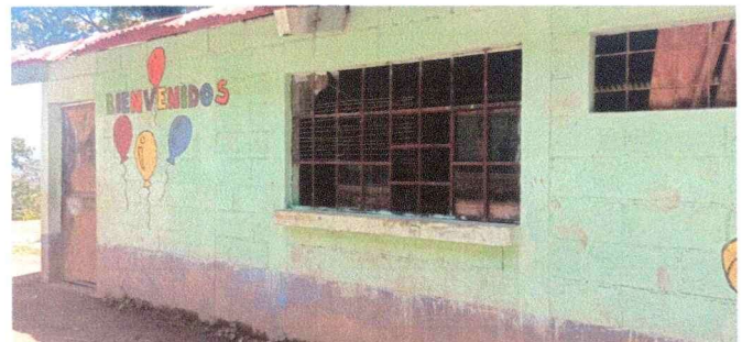
Foto 4: Sustitución de balcones y colocación de vidrios
