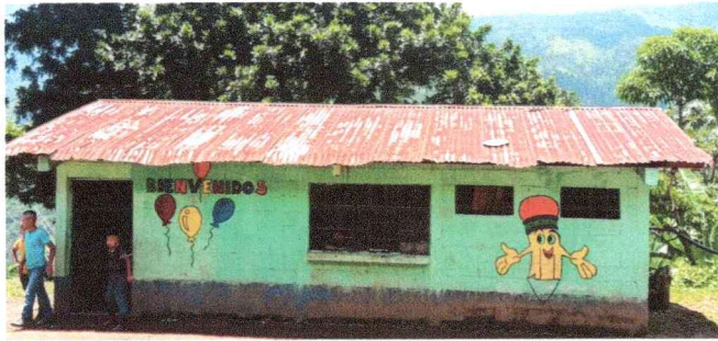
Foto 3: Sustitución de láminas, puertas y costaneras
