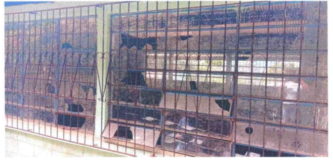
Foto 2: Sustitución de vidrios quebrados
